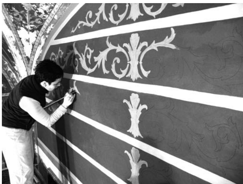
Fig. 11 Aplicació de pintura damunt el nou suport
