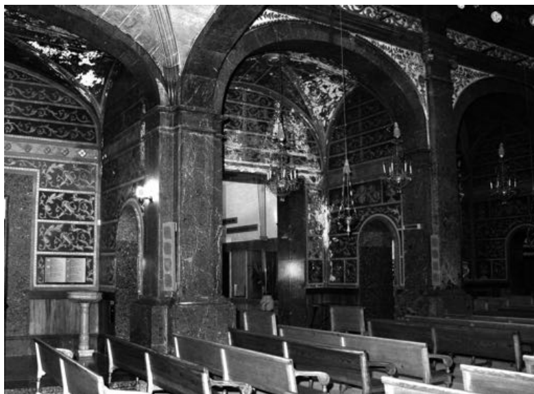
Fig. 1 Aspecte general abans de la intervenció
