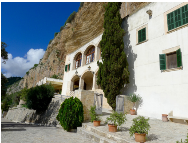
Fotografía: Elaboración propia
