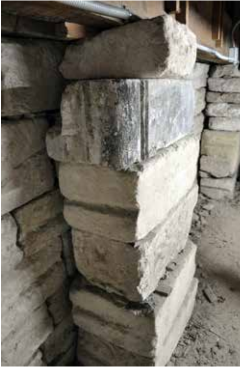
Fig. 29. Fotografia en què s'aprecien les incisions, tant horitzontals com verticals, practicades sobre algunes pedres que conformen els pilars. Font: elaboració pròpia.
