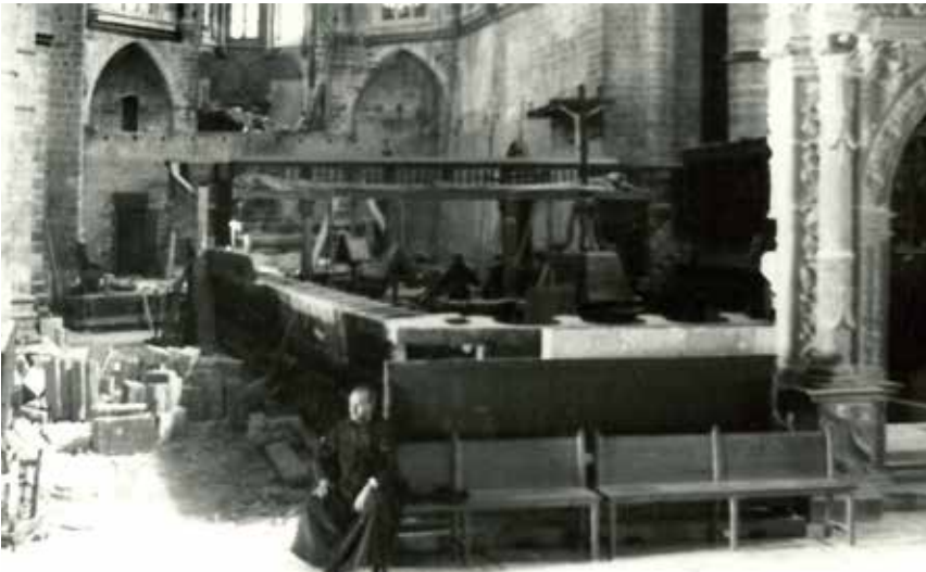
Fig. 18. Detall d'una imatge presa per Sagristà el mateix 23 de juliol, en què es poden veure amuntegats, a l'esquerra de la fotografia, els carreus de pedra que s'han desmuntat del recinte coral. Arxiu fotogràfic d'Emili Sagristà (ACM). Font: Gambús Saiz, M. (2015). «Les fonts de [...], figura 26, pàg. 541.
