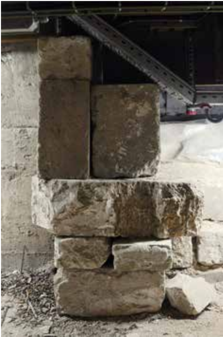
Fig. 28. Imatge on es veu clarament la superposició de carreus que conformen els pilars de l'interior de la caixa harmònica. Font: elaboració pròpia.
