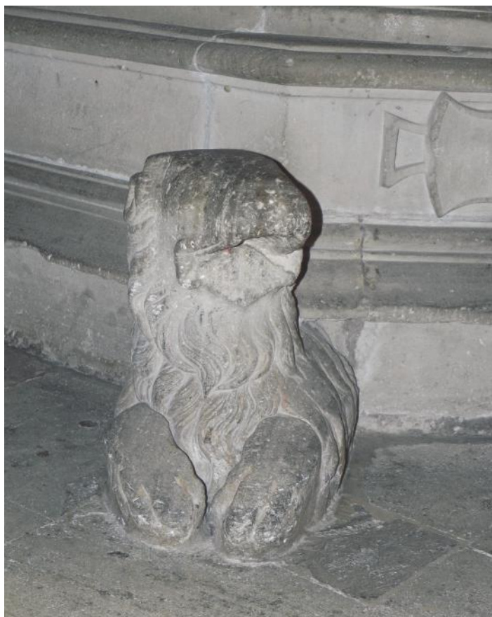
Fig. 8. Detall del gastat de la pedra en un dels lleons de la trona grossa
