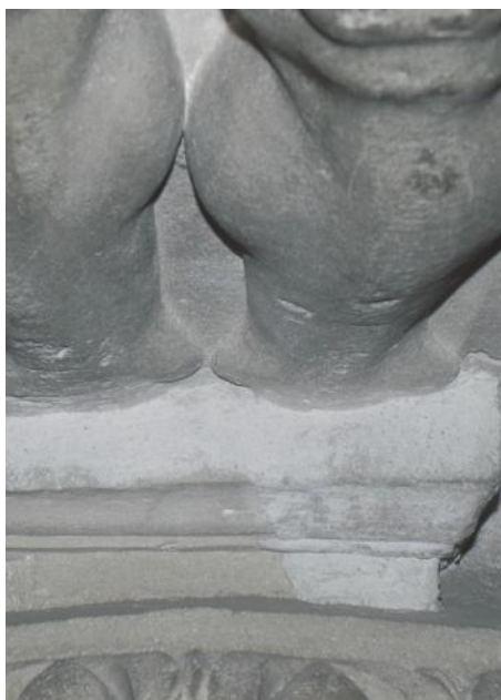
Fig. 11. Morter amb doble finalitat: subjecció i reintegració volumètrica
