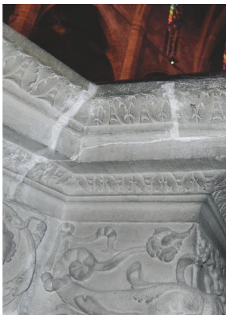
Fig. 10. Morter de muntatge o de subjecció dels diferents carreus
