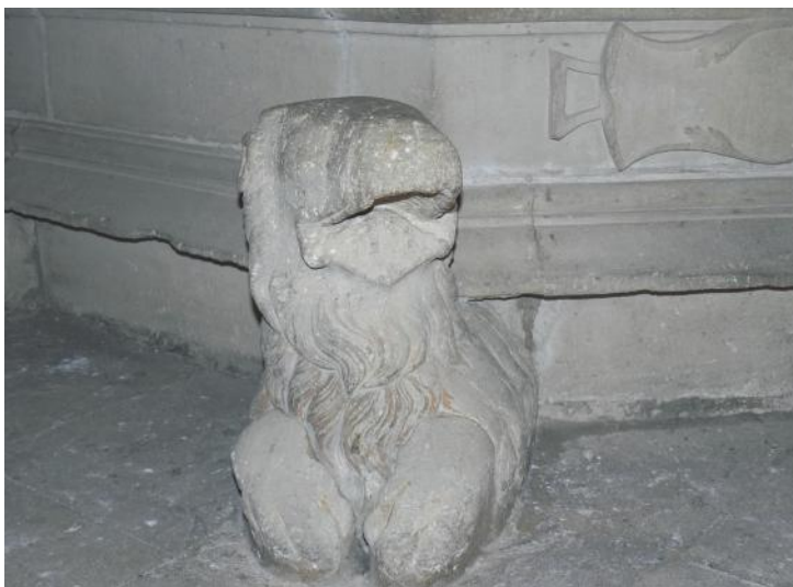
Fig. 20. Detall de la pàtina localitzada als lleons de la trona grossa
