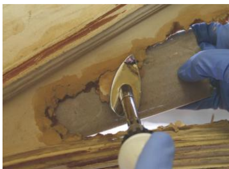
Fig. 19 y Fig. 20. Proceso de consolidación del cartón
