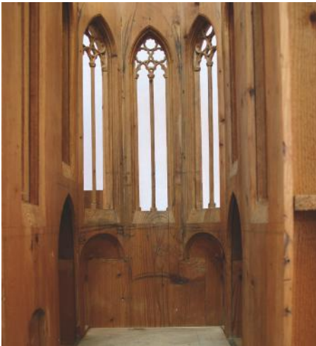
Fig. 7. Ábside de la Trinidad
