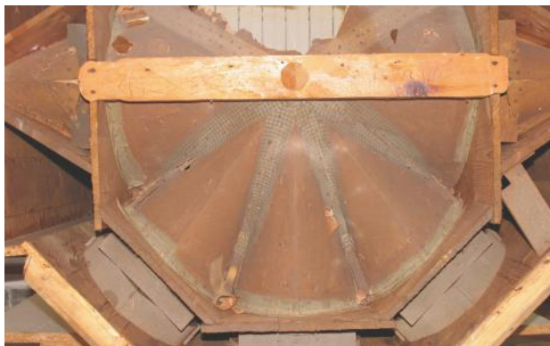
Fig. 12. Sistema constructivo de la bóveda
