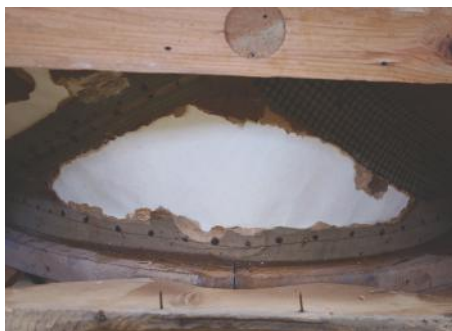
Fig. 21. y Fig. 22. Reintegración de las bóvedas de cartón
