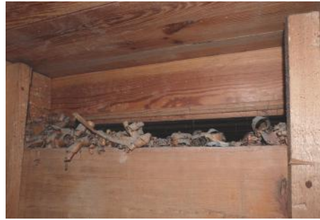
Fig. 2. Restes del moment de la construcció
