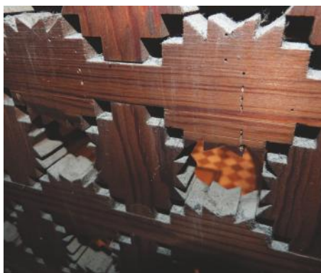
Fig. 49. Estat de conservació de l'interior de les tribunes corals
