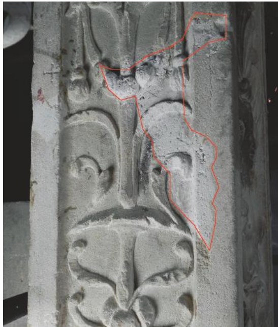
Fig. 39. Utilització del morter com a matèria de reintegració volumètrica
