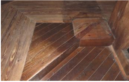
Fig. 5. Restes de l'acabat original i del vernís de poliuretà
