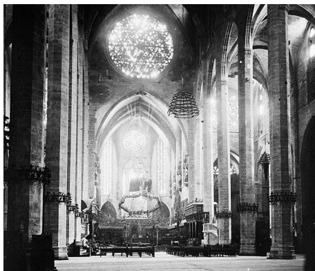
Fig. 2. L'interior de la Seu després de la restauració l'any 1915. Fons Josep Salvany i Blanch.
